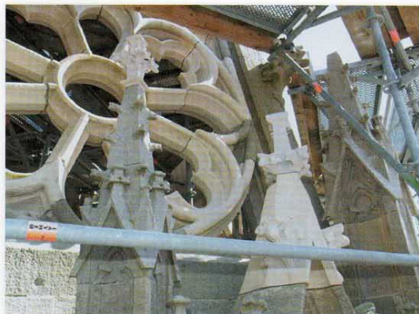
図10 修復作業が終った部位
