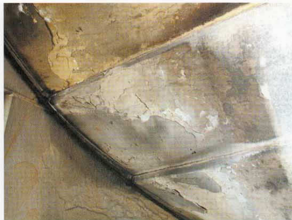
図8 主塔の階段（裏側）
